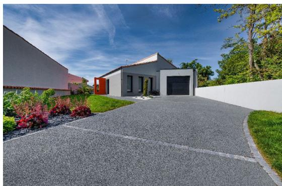
Le béton micro-désactivé de la gamme Lumiliss® Micro-désactivé est une des solutions d'EDYCEM BPE. **La surface de ce béton est travaillée de manière à ne laisser apparaître en surface que des granulats, pour un aspect naturel sablé.**
