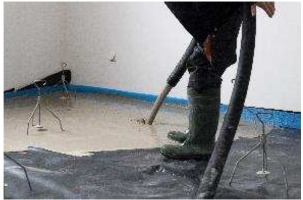
Chantier chape fluide EDYCEM BPE Crédit photo : Charles Marion
